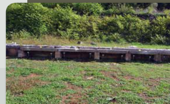
Ανατολική Στοά. Θρανία ανατολικής πλευράς. Πριν και μετά τις εργασίες συντήρησης, συγκόλλησης και αποκατάστασης. East Stoa. The desks in the east side. Before and after the conservation and restoration activities.
