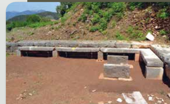
Ανατολική Στοά. Θρανία βόρειας πλευράς. Πριν και μετά τις εργασίες συντήρησης, συγκόλλησης και αποκατάστασης. East Stoa. The desks in the North side. Before and after the conservation and restoration activities.
