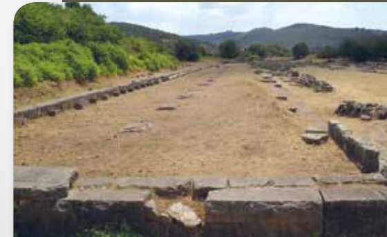
Ανατολική Στοά. Πριν και μετά τις εργασίες καθαρισμού. East Stoa. Before and after the cleaning activities.
