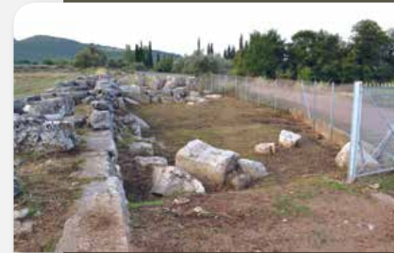
Οχυρωματικός περίβολος, Δυτικό τμήμα. Πριν και μετά τις εργασίες καθαρισμού και αντικατάστασης της παλαιάς περιφράξης. Fortification wall. West part. Before and after replacement of the old fence.
